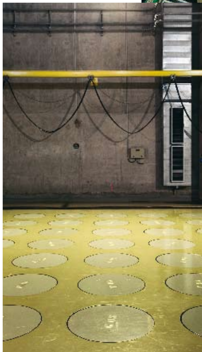
↑ In attesa. Nel deposito Areva di La Hague i rifiuti più pericolosi, impilati in pozzi, aspettano una destinazione definitiva. Ci sono anche quelli italiani.
