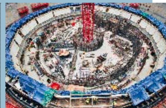
↑ Flamanville: la base del nuovo reattore Epr in costruzione.
